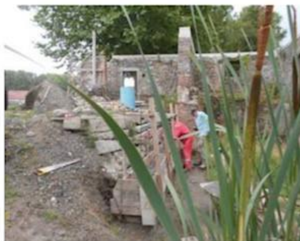
Les bénévoles s'activent sur le chantier. © PAUL LESTERLOU
