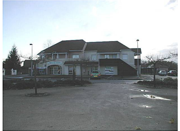
Commerces, parkings, et place aménagée du centre bourg
