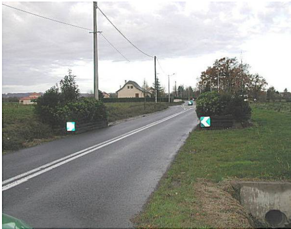
Une entrée d'agglomération aménagée et arborée
